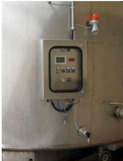
**6) Installazione del quadro di controllo,** dal quale è possibile gestire in automatico la temperatura, l'apertura dei bypass e l'iniezione dei gas tecnici (macro-ossigenazione, controllo temporizzato della CO<sub>2</sub> per la macerazione pellicolare dinamica prefermentativa).
