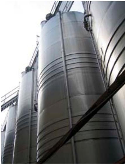
**5) Saldatura di tasca di raffreddamento sul fasciame:** qualora necessario, il serbatoio viene termo-condizionato con l'applicazione di tasche a canalina o a mantello che vengono saldate sul cilindro del serbatoio.
