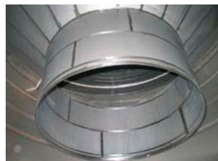
**4) Saldatura interna degli spicchi a formare il diaframma ad imbuto:** il diaframma "ad imbuto" viene ricomposto con un accurato lavoro di saldatura ad opera di personale qualificato.
