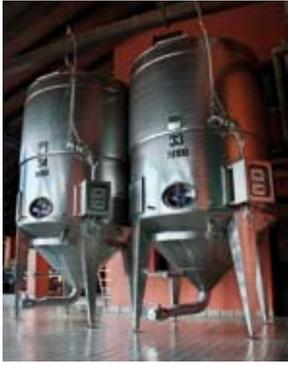
**El Método Ganimede®** permite introducir, a través de una especial válvula, gases técnicos directamente en el espacio libre que hay debajo del diafragma. De esta manera es posible obtener una acción más eficaz respecto a la obtenible en un depósito tradicional. Con el **Método Ganimede®** las condiciones químico-físicas necesarias para una correcta disolución del gas en el líquido (presión, superficie y tiempo de contacto, temperatura) son respetadas.
