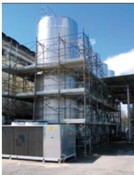
**2) Подготовка лесов:** внутренние и наружные леса нужны для безопасного проведения сварочных работ на мембране, а также для сварки байпасных клапанов и наружных карманов охлаждения.
