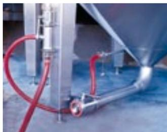
Коническое дно с устройством "Sluice Point"
