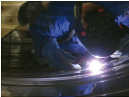
2) Preparación de los andamios: los andamios internos y externos son necesarios para realizar con seguridad los trabajos de soldadura del diafragma, de las válvulas de bypass y de las posibles camisas externas de refrigeración.
