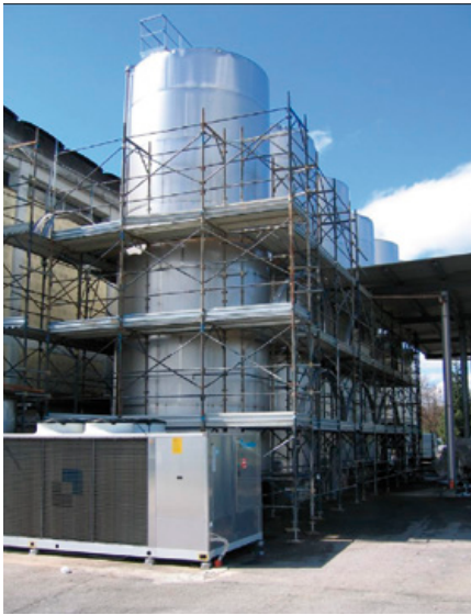
2) Preparación de los andamios: los andamios internos y externos son necesarios para realizar con seguridad los trabajos de soldadura del diafragma, de las válvulas de bypass y de las posibles camisas externas de refrigeración.
