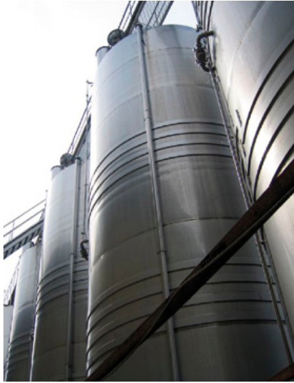
5) Soldadura de la camisa de refrigeración en la virola: cuando sea necesario, el depósito se acondiciona térmicamente aplicando camisas que se saldan en el cilindro del depósito.
