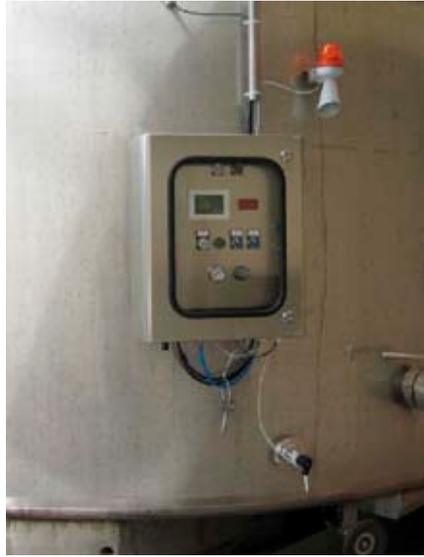
**6) Installation du tableau de contrôle,** à partir duquel il est possible de gérer en automatique la température, l'ouverture des bypass ainsi que l'injection des gaz techniques (macro-oxygénation, contrôle temporisé du CO<sub>2</sub> pour la macération pelliculaire dynamique préfermentaire).
