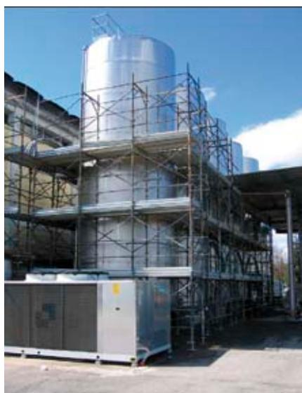
**2) Préparation des échafaudages:** les échafaudages internes et externes sont nécessaires pour effectuer en toute sécurité les travaux de soudage du diaphragme, des soupapes bypass et des chambres externes de refroidissement.
